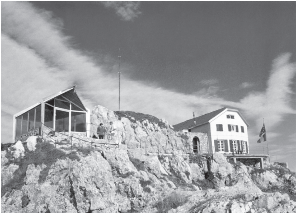
Il rifugio Brioschi oggi. A sinistra la cappellina di Santa Maria della Strada, inaugurata nel 1961 dal cardinal Martini
