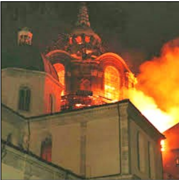
16. Incendio nel Duomo di Torino nel 1997
